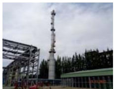
Thermal Oxidizer (TO) ระบบ Three Stage Combustion
